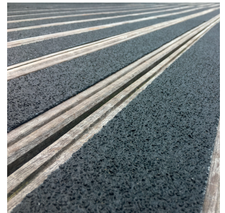
MONTAGE OP HOUT
